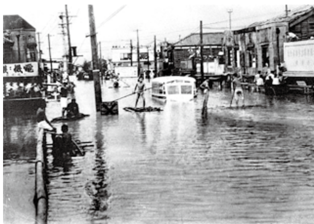
1947 年 9 月 7 日カスリーン台風による水害状況 （東京都水害誌）
