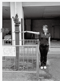
沈下前の地盤高
