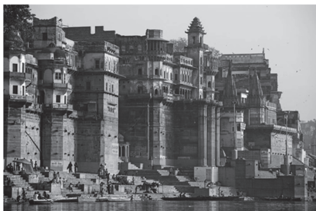
図7 ガート上の建物の造り
