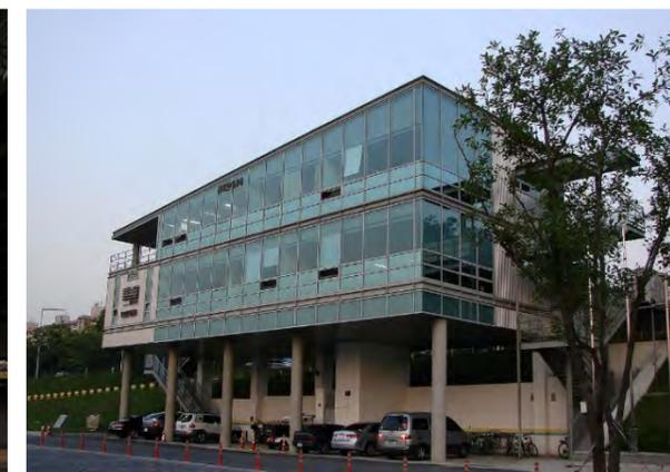
図 12 浸水水位を考慮したピロティ構造の建築物
