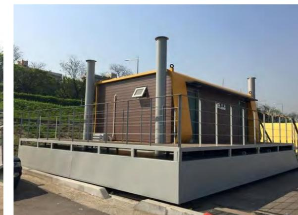
図 10 下部にタンクが設置されているフローティング式のトイレ
