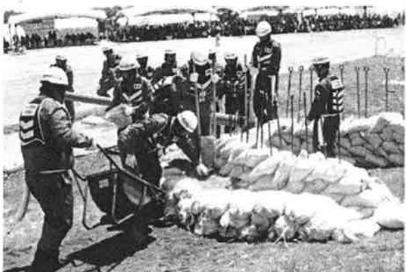
破堤を仮修復する「月の輪工法」
