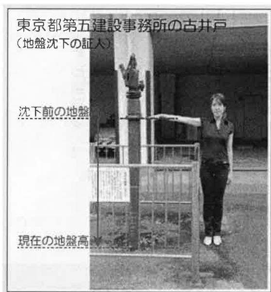
ステンレスの柵の説明文によると、このポンプは昭和13年に当時の中川改修事務所が設置し、昭和21年に深さ60m迄増し掘りされたとある。この豊富で良質な水を青写真の水洗い等に多用した五建出身者が現在もなお健在であるという。折しも戦後の急成長期で葛飾江戸川江東一帯では工業用水の汲み上げ増大と、直下で発見された天然ガスの大量採取が開始された。このため周辺の地盤は年間5~10cm程沈下するようになり、揚水規制法が効力を発揮する迄25年以上に亘り地盤沈下が続き、深い所では海面より4mも低いゼロメートル地帯となってしまった。この経緯を物語る貴重な生き証人が、五建と都営住宅の建て替えのため撤去される事を知り当NPOは、2010年10月これを保存しようと「広域ゼロメートル市街地研究
