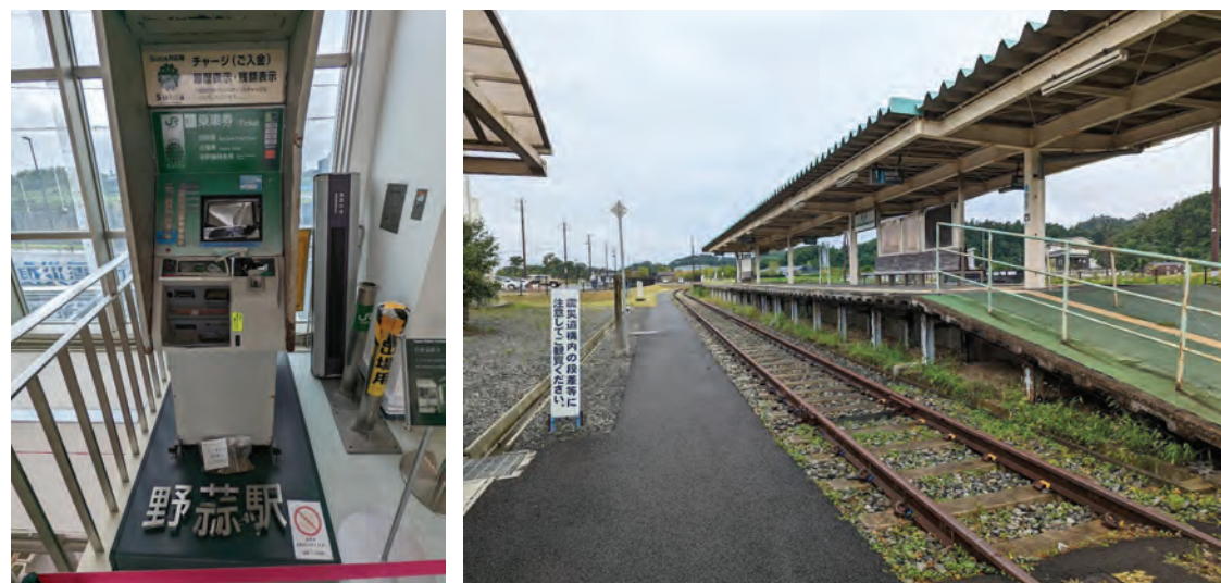
震災遺構 （左）津波で破壊された 旧・野蒜駅の券売機 （右）旧・野蒜駅のホーム
