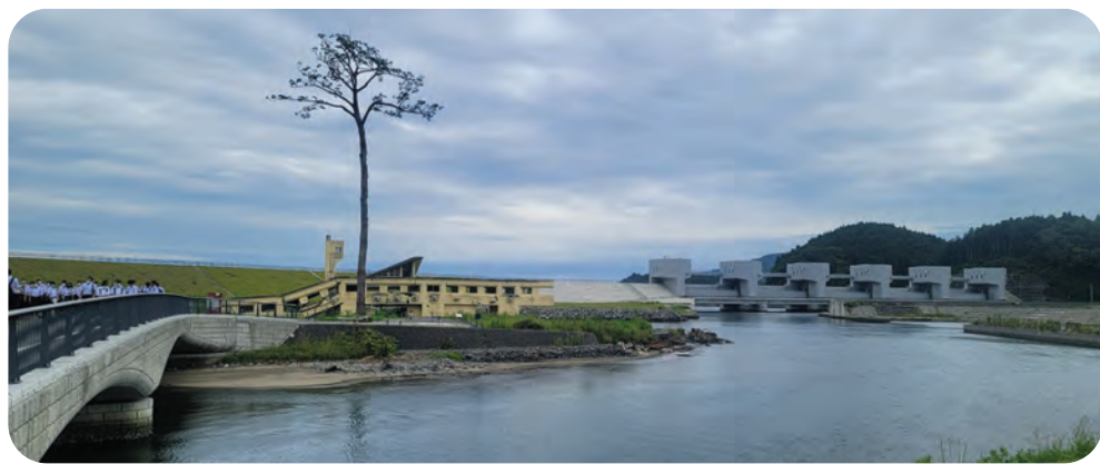
資料：筆者の撮影写真、津波にも生き残った松の一本
