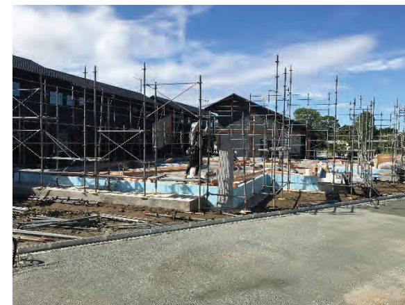
図 1 建設中の災害公営住宅
