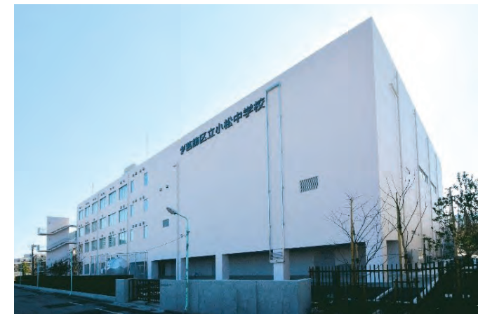
浸水対応型拠点建築物への建て替えが完了した小松中学校
