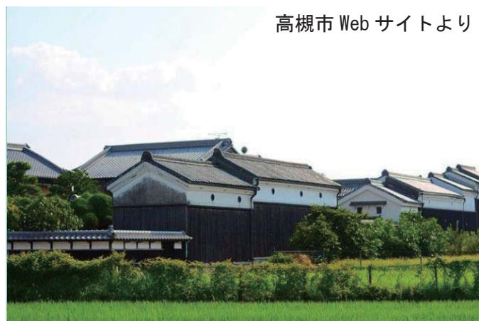
伝統的な“浸水対応型”建築（左：淀川の段蔵、右：木曽三川・輪中地域の水屋）
