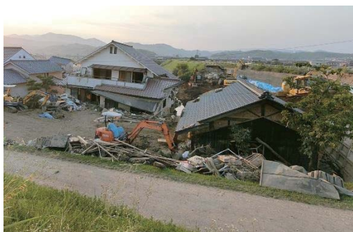
決壊点近くの倒壊建物
