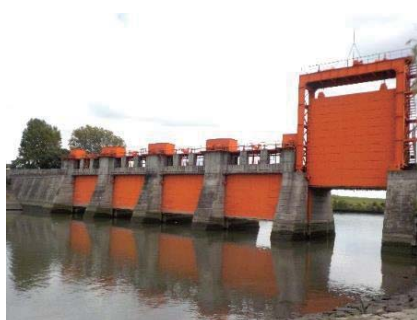
旧岩淵水門の見学
