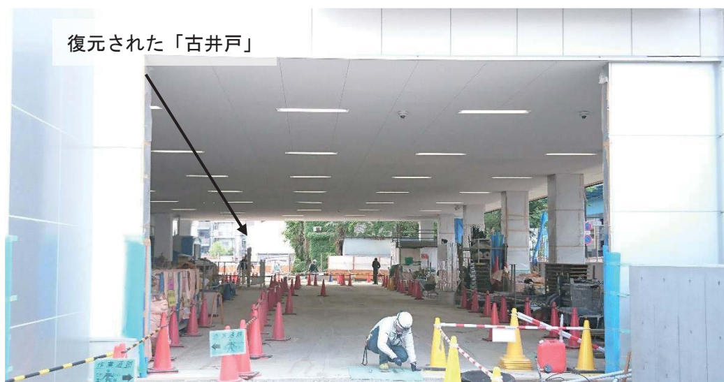
工事中の東京都第五建設事務所とピロティ内に復元された「古井戸」
